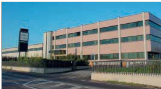
La sede di Elettrondata a Spezzano.
