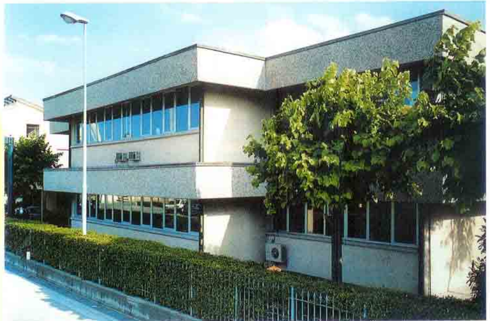
Uffici posti all'interno del cantiere di Salvaterra
